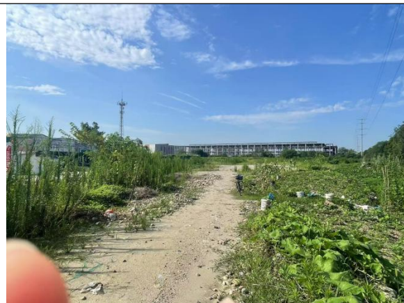
施工营地现状
